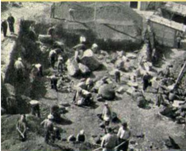
Els treballadors acabaven l'excavació per als fonaments del centre emissor.
