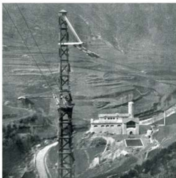
Vista des d'Engolasters de l'antena i del centre emissor ja pràcticament acabat.
