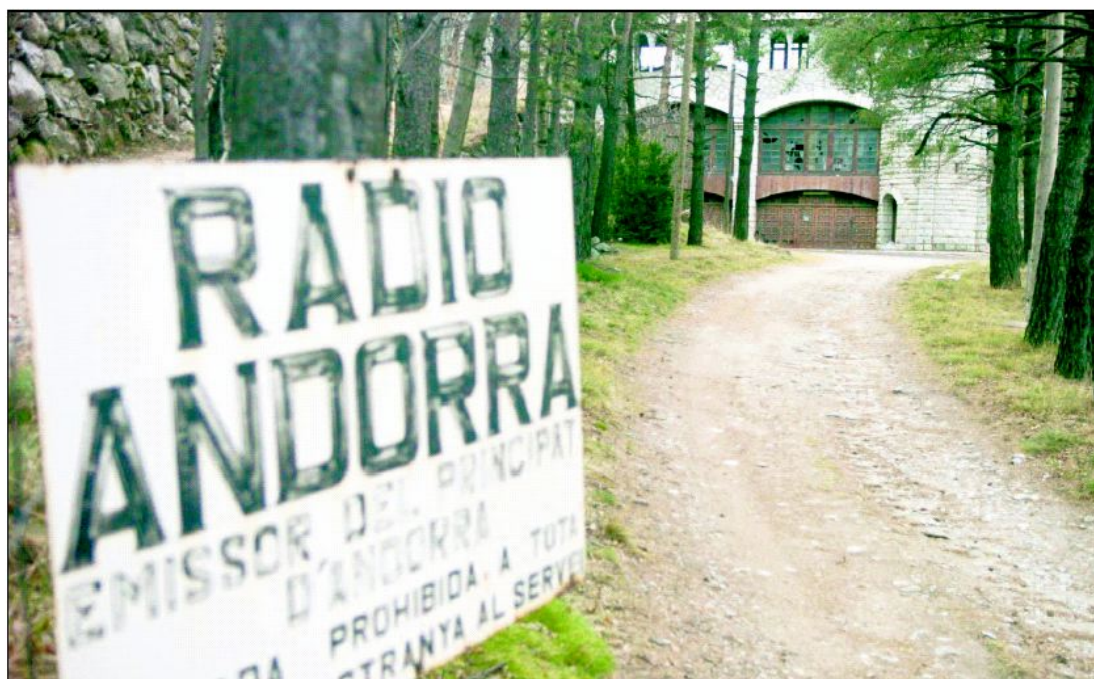
Les instal·lacions que van acollir Radio Andorra presenten un estat de degradació força elevat.
