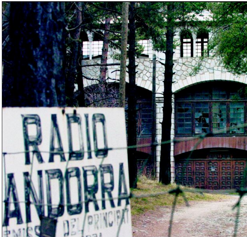
L'edifici de Radio Andorra es troba en molt mal estat després de tres dècades sense ús.
